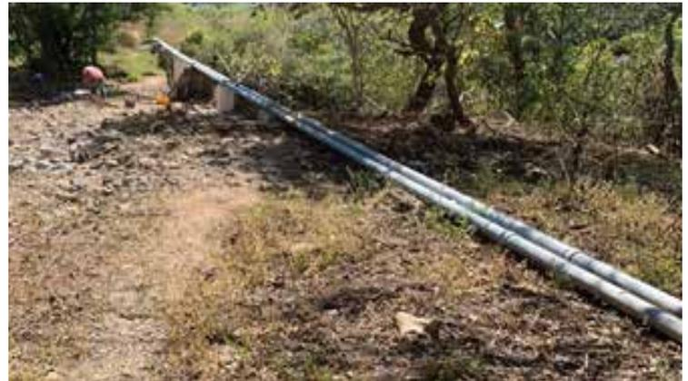
2.- Reparación y conexión del agua potable con tubo galvanizado con rosca de 3" C-40, ubicada en el lugar conocido como la compuerta en la cabecera municipal de Ejutla, Jalisco, con un monto de \$60, 260.87, iniciando el 07 de diciembre del 2021 y culminando el 16 de diciembre de 2021, beneficiando a todos los pobladores de Ejutla y turistas de la región.
